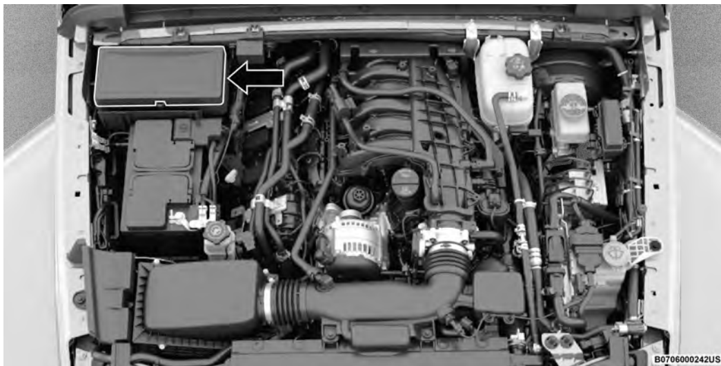
Ubicación del centro de distribución de energía – Motor de gasolina
